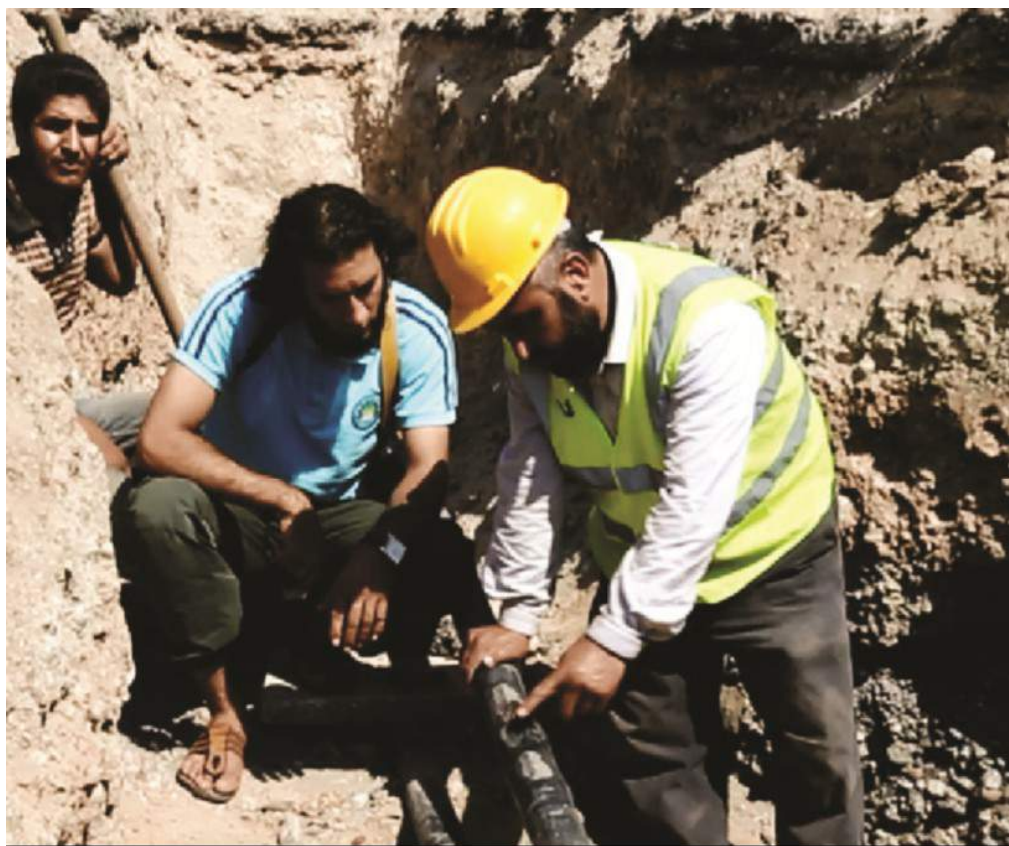
Lavoratori assegnati dallo Stato Islamico ripristinano la rete elettrica
